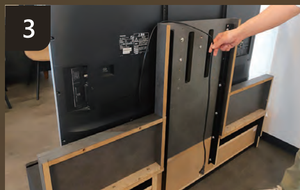
テレビ裏のスペースを通して、配線できます！この部分に配線を隠せるので、便利です！
